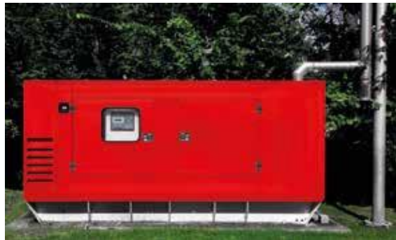
Notstromaggregator mit separatem Auspuffrohr
